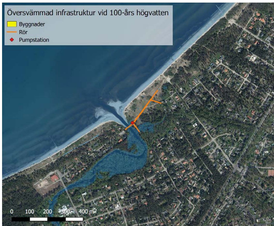
Figur 5-11 Översvämmad infrastruktur vid Hemmeslövsstrand vid ett 100-årshögvatten år 2015 (+2,1 m RH2000).
